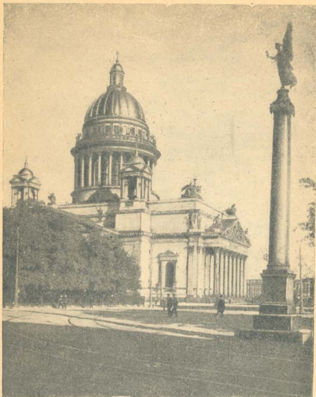
Рис. 1. Исаакиевский собор (Монферран, 1819—1859 гг.). Наружная облицовка стен — рускеальский мрамор; внутренняя облицовка (колонны, пилястры, панели, пол и др.) — тивдийский мрамор, шокшинский кварцит, нигозерский сланец, соломенская брекчия; колонны — финляндский гранит. Колонна «Славы» (справа) — сердобольский гранит.
